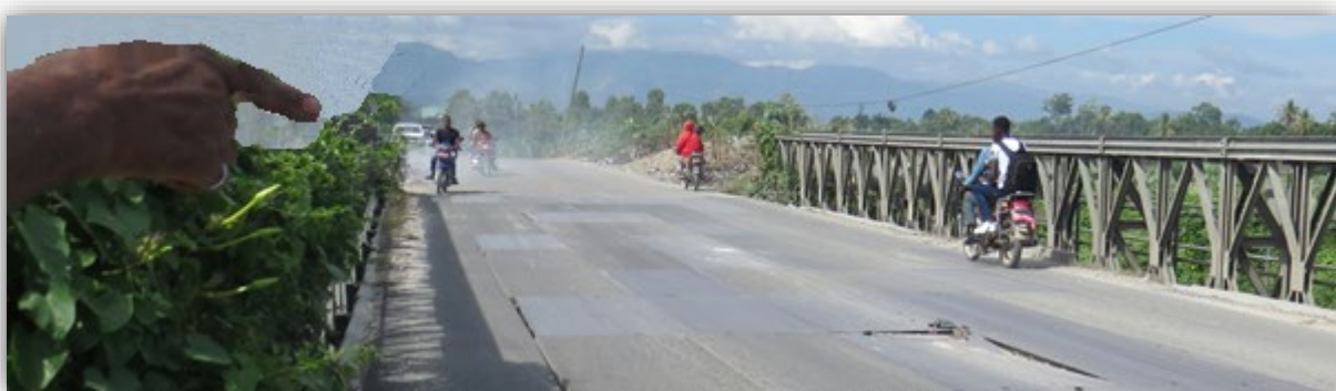
La main indique une dalle endommagée sur le pont
