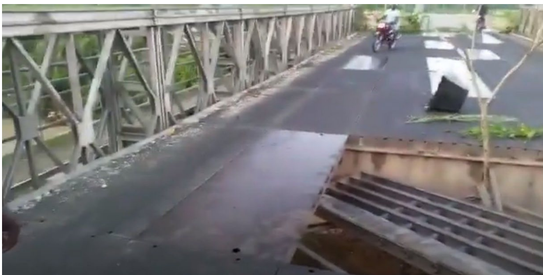
Une image du pont sans quelque dalle
