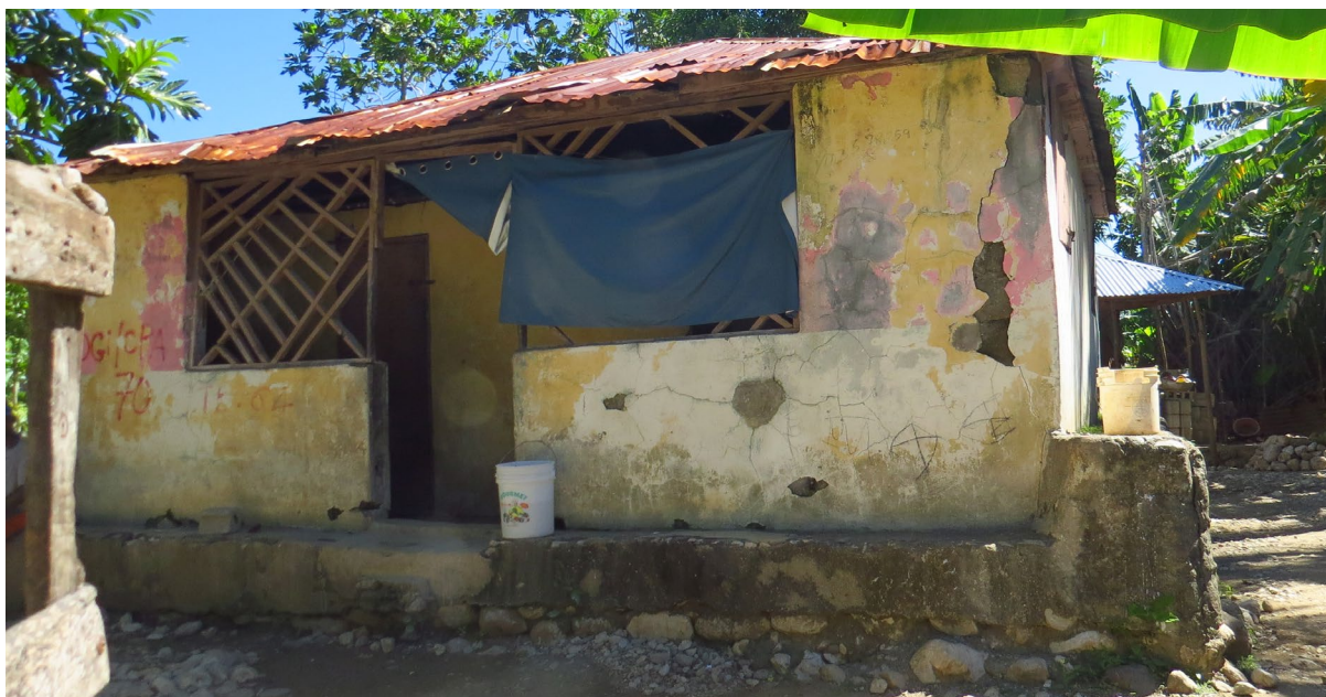
Fig. 3 – Une des maisons à démolir
