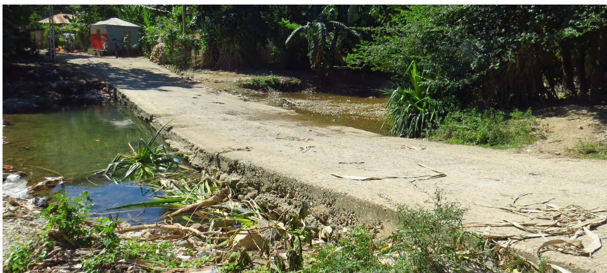
Fig. 2 – La localisation du Pont 5 au km 25+700
