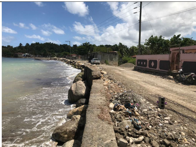
Déviation pont 2, pk 17+600
