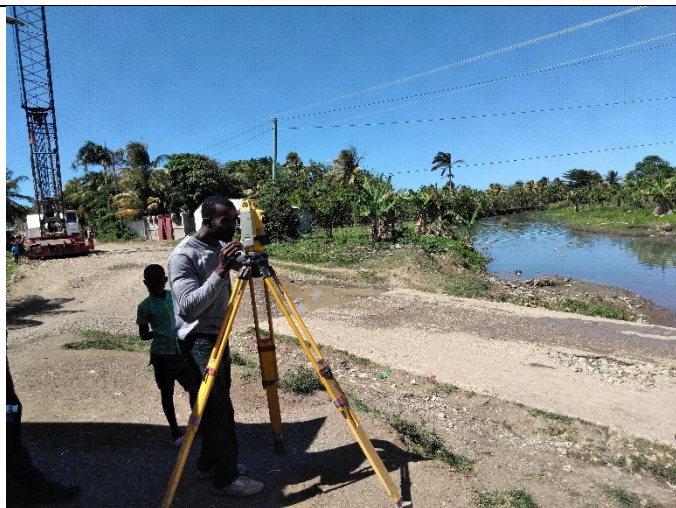
Travaux d'implantation pont 3, pk 17+800
