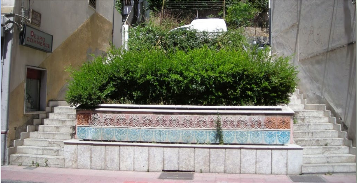
come si presenta oggi la scalinata di accesso al Viale delle Rimembranze
