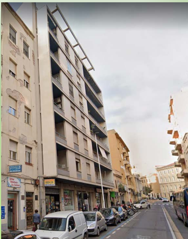
Lo stabile di via XX Settembre a Cagliari
